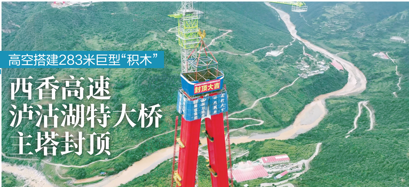
泸沽湖特大桥香格里拉岸主塔吊装现场。蜀道集团供图
