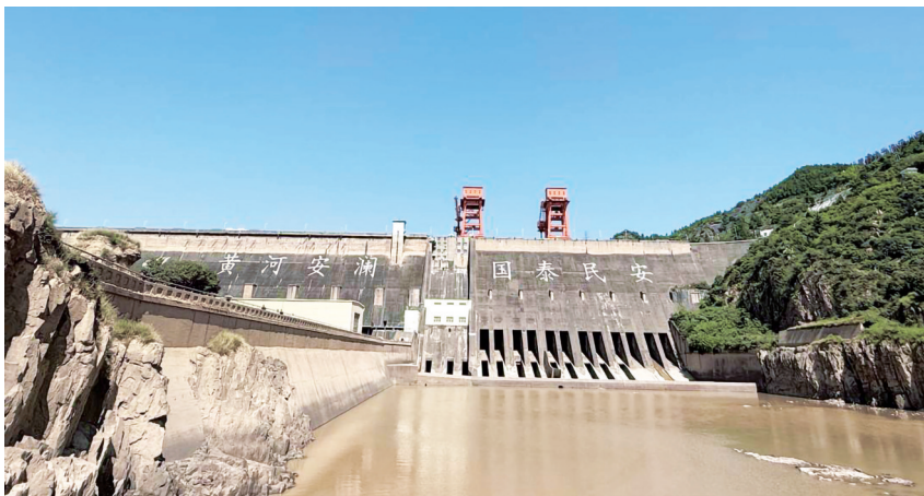
三门峡水利枢纽工程。
