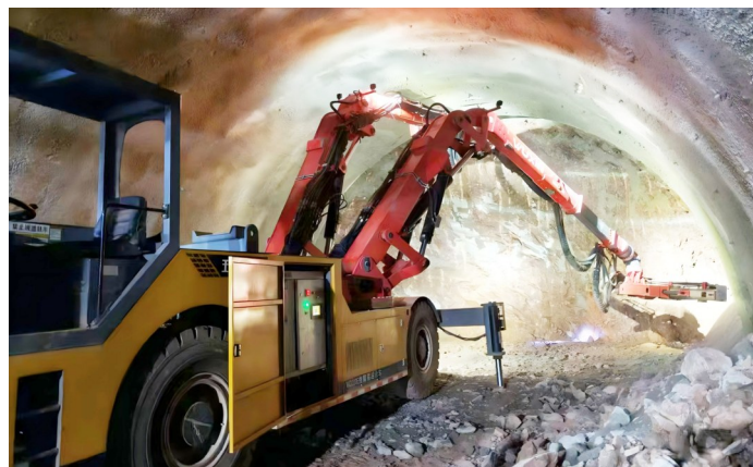
乌东德隧道内部施工现场。蜀道集团供图
