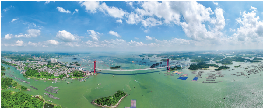
8月20日拍摄的平陆运河出海口附近的龙门大桥。新华社记者 曹祎铭 摄
