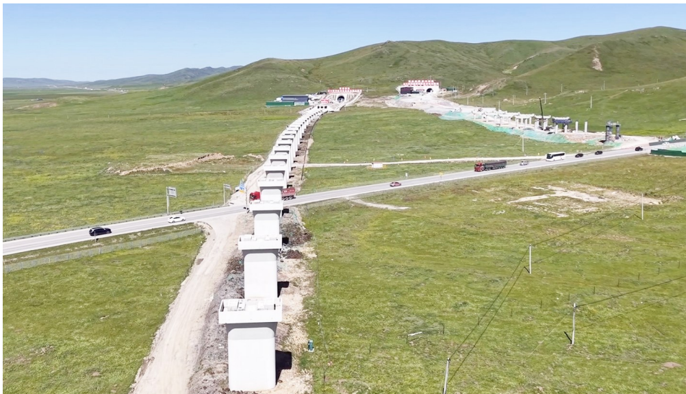
公铁双线两座日尔郎山隧道平行掘进。成兰铁路公司供图
