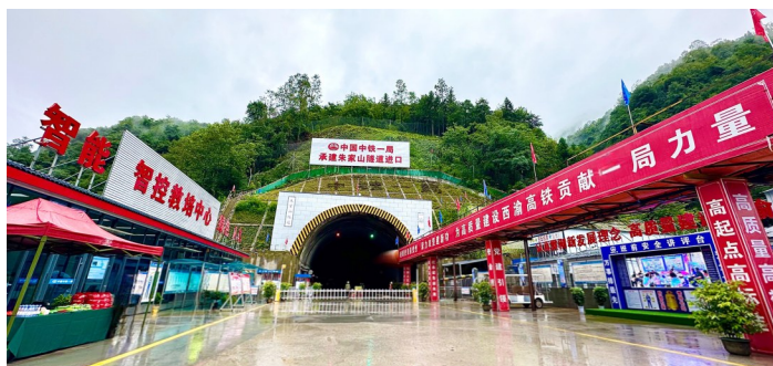
朱家山隧道洞口。京昆高速铁路西昆有限公司供图
