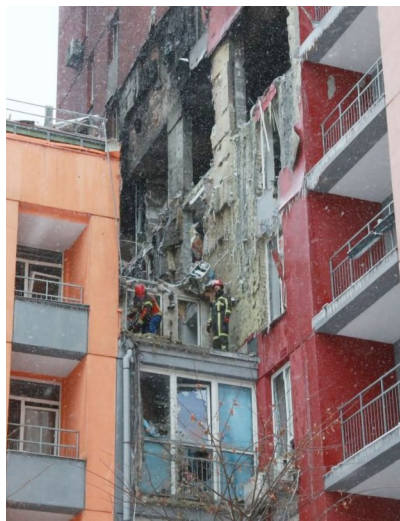
▲这是2026年1月9日拍摄的乌克兰首都基辅市第聂伯区一栋被无人机击中的公寓楼。 新华社记者 李东旭 摄
