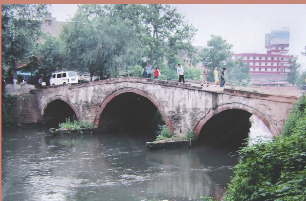
上三洞桥是清光绪年间修建的一座红砂石三孔平栏石拱桥。图据成都方志微信公众号
