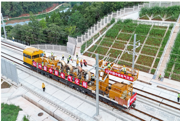
在作业车和施工人员的配合下，接触网导线成功架设。 长江沿岸铁路集团四川有限公司供图
