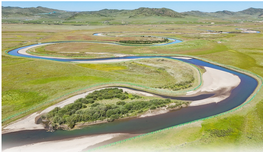
这是8月13日在阿坝州阿坝县拍摄的黄河一级支流贾曲河河道岸堤修复工程。 新华社记者 王曦 摄
