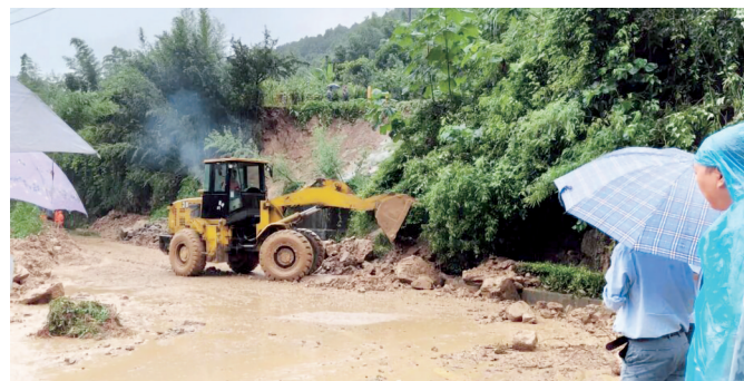
装载机到塌方现场开展清理作业。新华社发
