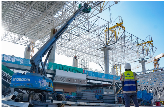
建设中的成渝中线高铁简州站。 长江沿岸铁路集团四川有限公司供图
