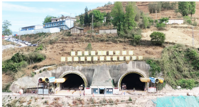
8月6日,位于凉山州普格县螺髻山镇的螺髻山隧道顺利贯通。
