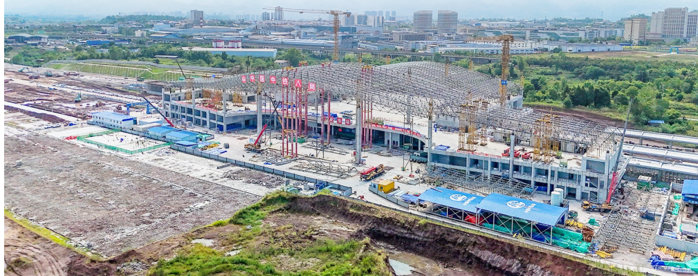
8月6日,广安东站主体结构完工。京昆高速铁路西昆有限公司供图
