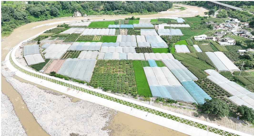
7月,凉山州德昌县安宁河堤防工程全面建成投用。图据德昌县融媒体中心
