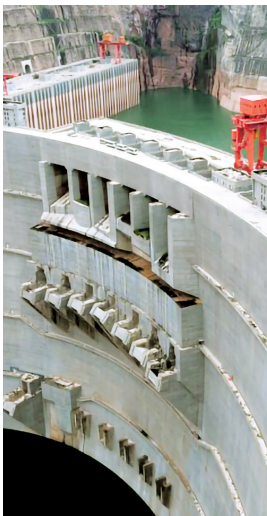
白鹤滩水电站拱形大坝上的泄洪孔。
