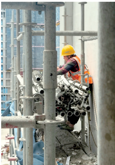
邹品芝在工地上收集钢管。
