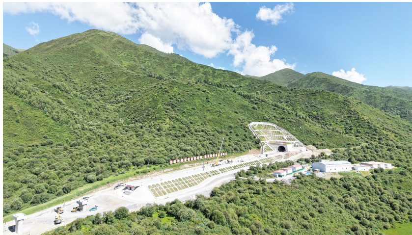
包座隧道所在位置周边环境。成兰铁路公司供图
