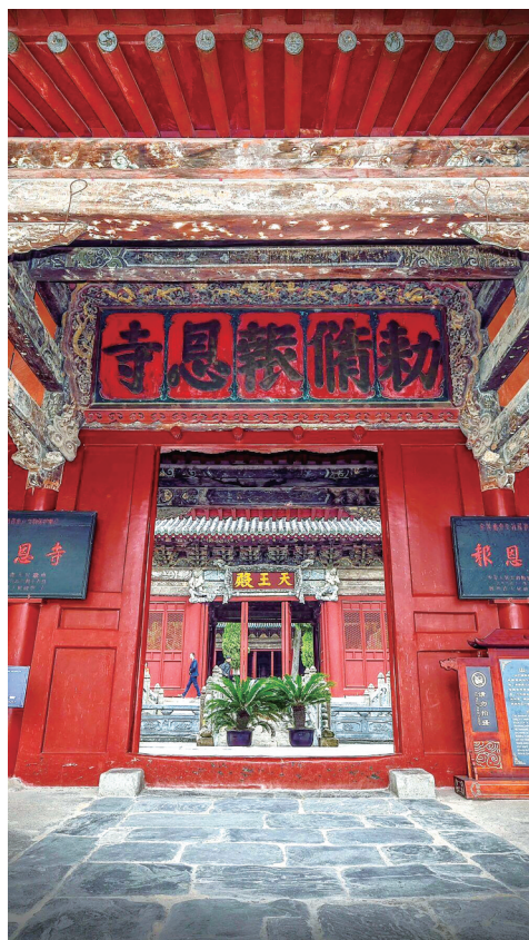
平武报恩寺是我国保存最完整的明代木结构建筑群之一。
