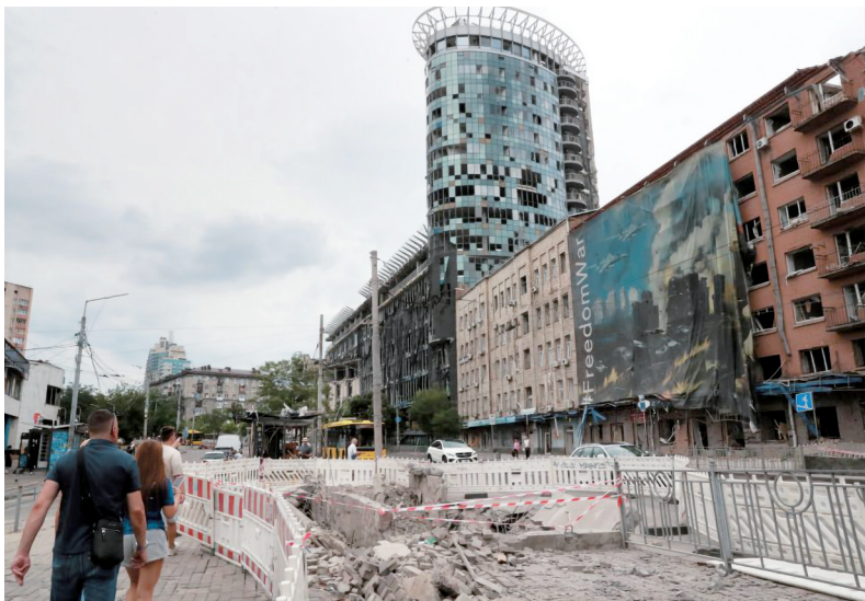
这是7月19日在乌克兰基辅市舍甫琴科夫斯基区拍摄的一处在袭击中受损的地下通道。 新华社记者 李东旭 摄
