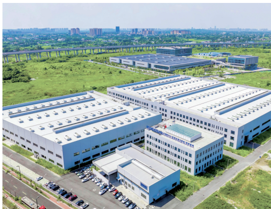
位于新都高新区的恒普氢能装备产业园。
