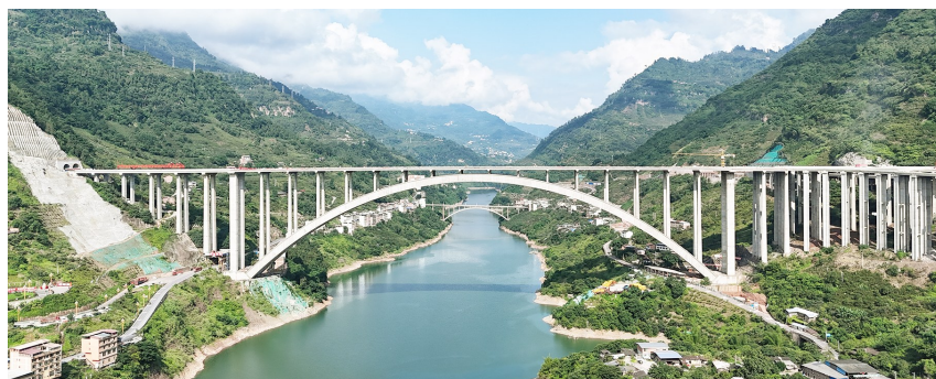
宜攀高速西宁河特大桥贯通。蜀道集团供图
