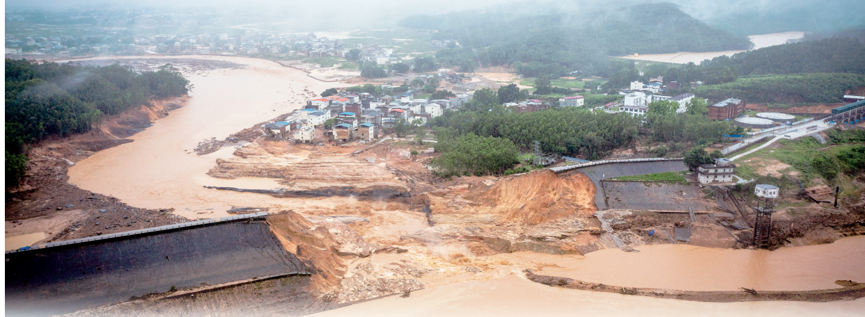
7月6日,广西横州六蓝水库坝体出现缺口。封面新闻记者 杨峰 摄
