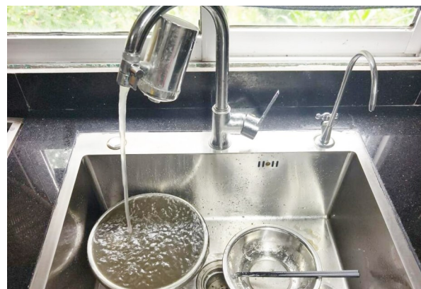
居民家水龙头放出的水浑浊发黑。受访者供图
