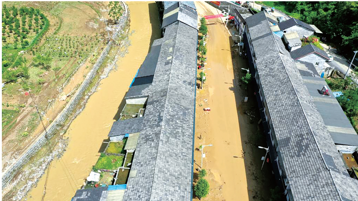
6月11日22时起,强降雨天气袭击贵州省遵义市。6月13日,大量淤泥覆盖遵义市正安县碧峰镇街道。新华社记者 刘续 摄
