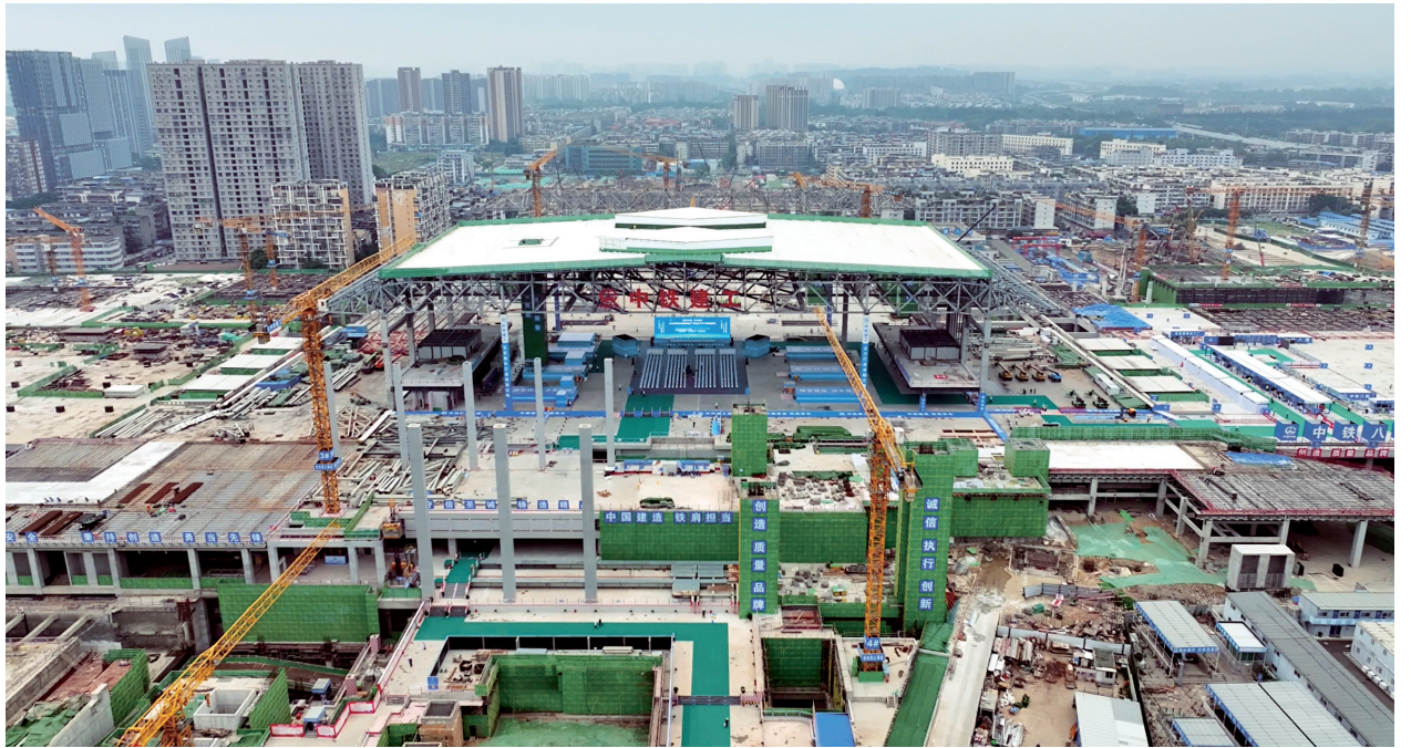
改造中的成都站俯瞰图。四川省住房和城乡建设厅供图
