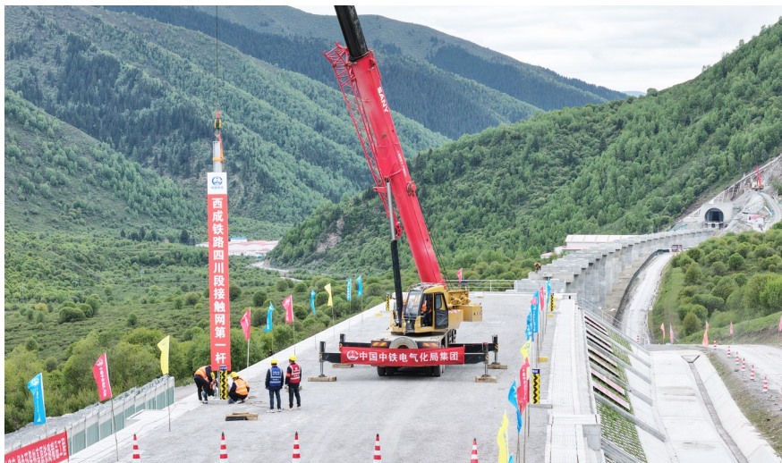
西宁至成都铁路接触网第一杆施工现场。成兰铁路公司供图
