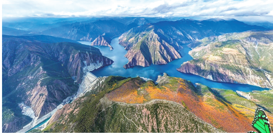
两河口水电站枢纽区全景。
