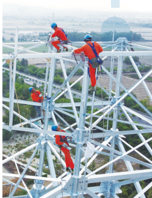
工人在架设输电基塔。
