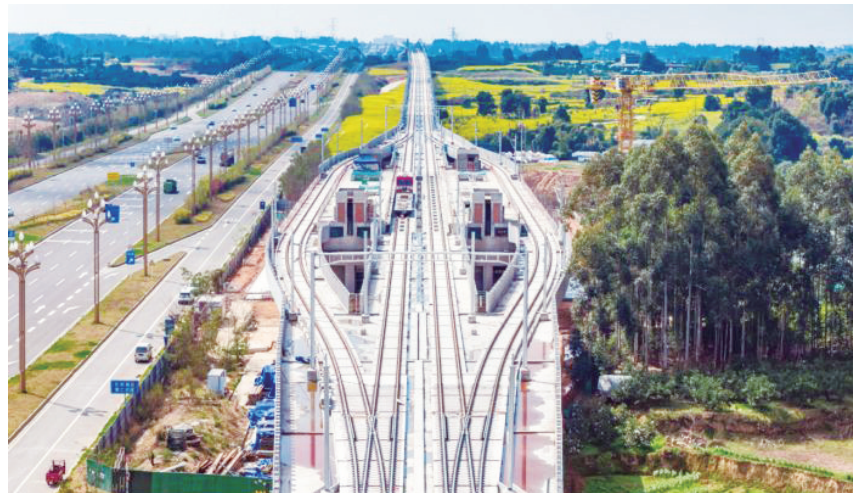
建设中的成眉S5线。图据川观新闻(省同城化办供图)
