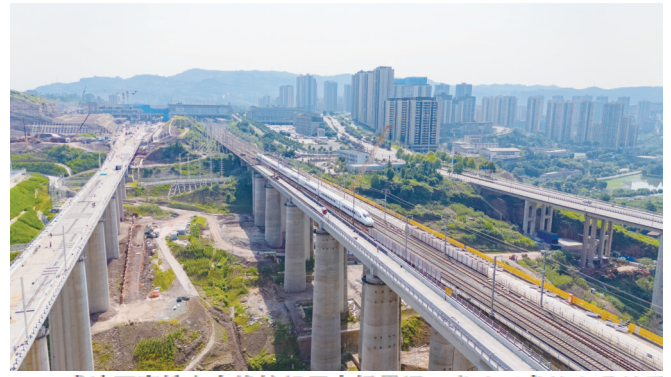
成达万高铁左右线纺织厂大桥贯通。成达万高铁公司供图
