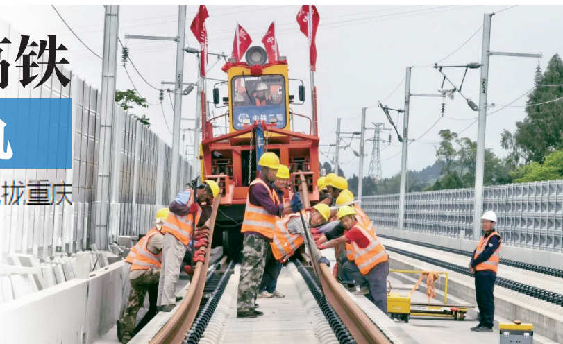
▲5月30日,成渝中线高铁跨成都东西轴特大桥,工人在铺轨施工。图据“西南铁路”微信公众号
