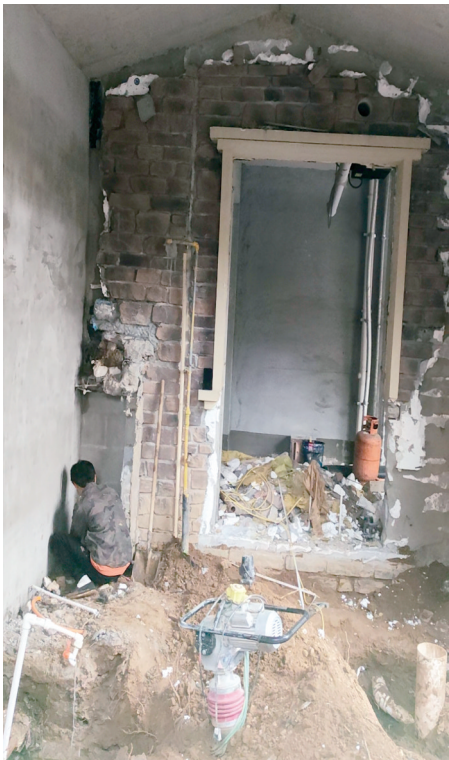
正在施工的违建现场。
