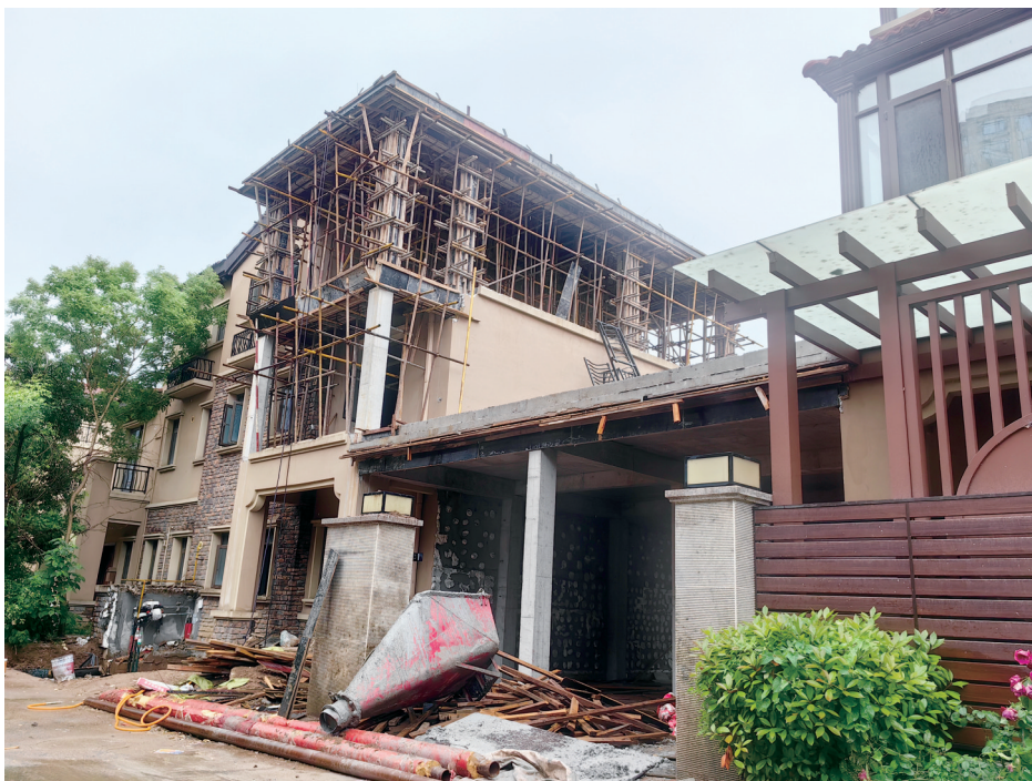
邢台碧桂园小区正在加盖的施工现场。
