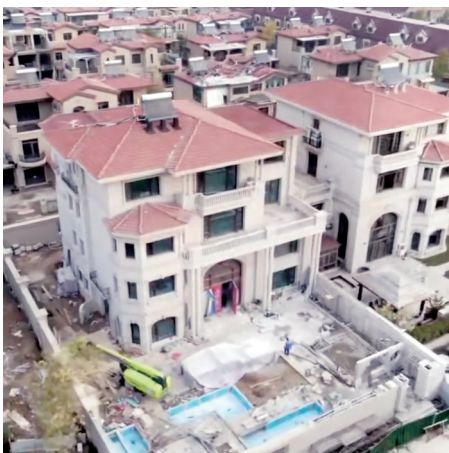
某栋别墅施工航拍。业主供图
