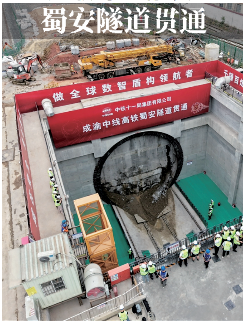
5月22日,成渝中线高铁蜀安隧道贯通。
