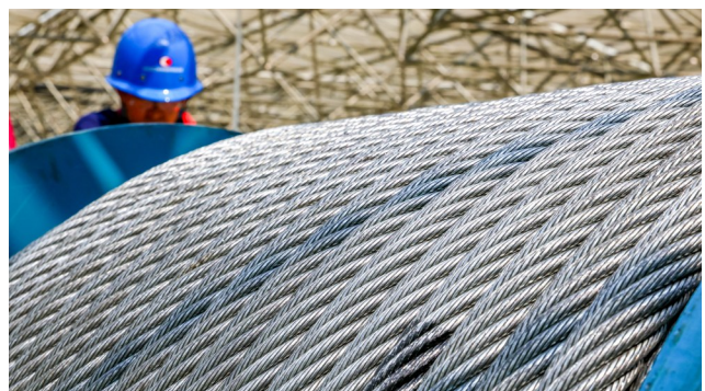
5月6日,工作人员将馈源驱动钢丝绳装入卷扬机。新华社发
