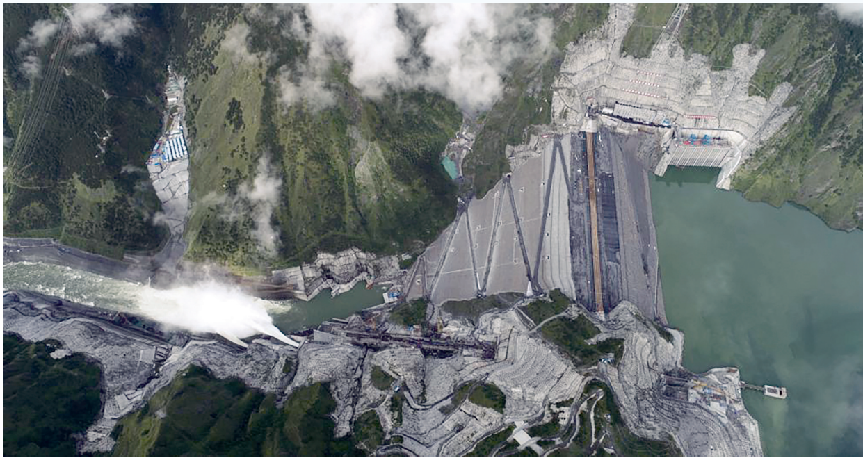
雅砻江两河口水电站大坝鸟瞰。图据新华社客户端
