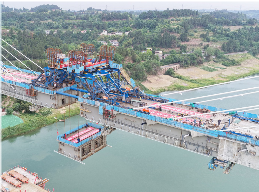
成达万高铁资阳沱江特大桥梁合龙施工现场。成达万高铁公司供图
