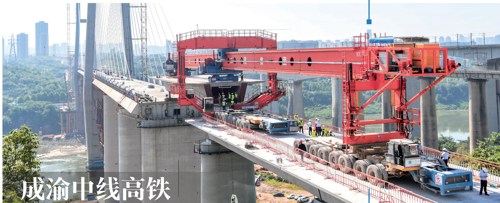
▲ 5月5日,工人在成渝中线高铁进行架梁作业。新华社记者唐奕摄
