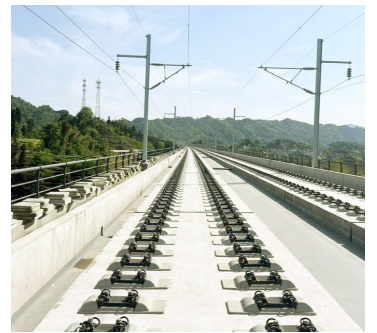
4月28日，渝昆高铁川滇段完成无砟轨道施工。京昆高铁西昆公司供图
