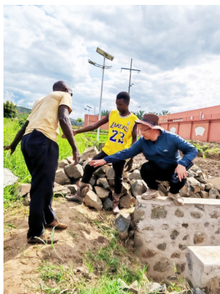
周小波指导布隆迪当地工人挖排水渠。
