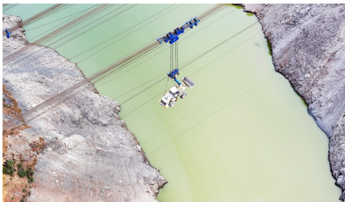
大型装载机通过缆索吊系统,从盐源岸运抵木里岸。
