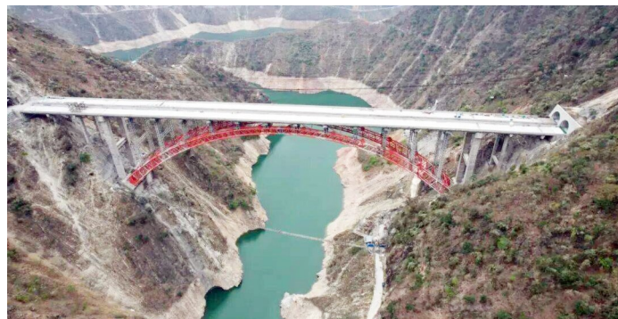
宜攀高速约乌拉达特大桥贯通。四川路桥供图
