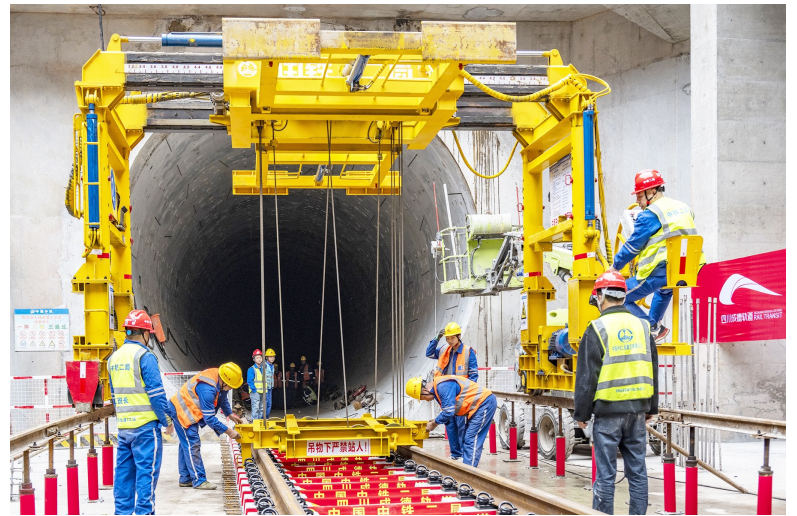
市域(郊)铁路成德线施工现场。成都轨道集团供图
