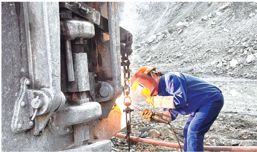
温馨在矿区电焊作业。
