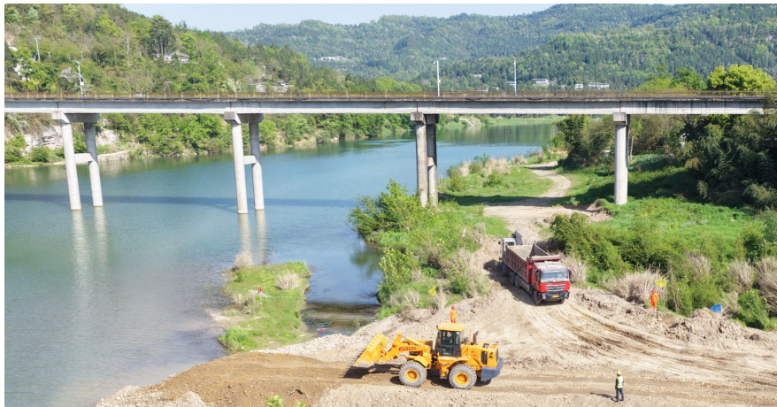
先期开工点东河特大桥施工现场。蜀道集团供图
