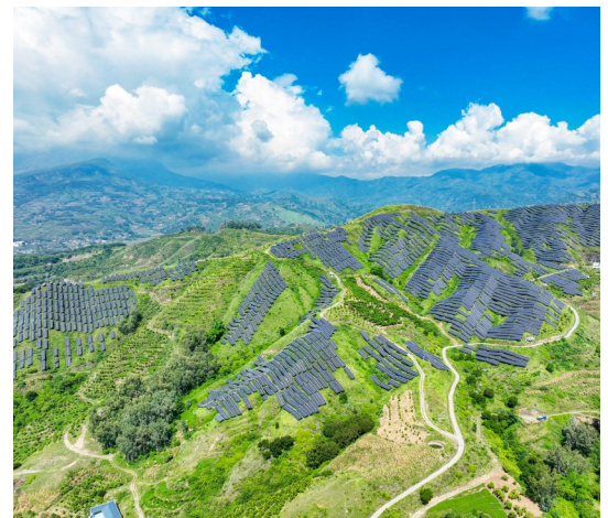
位于攀枝花平地镇的光伏发电站。陈艾嘉摄
