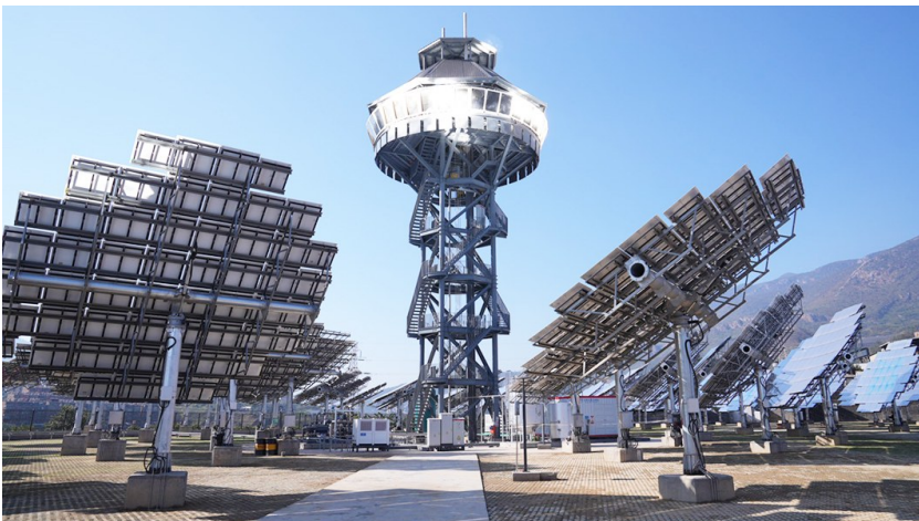
在工作人员操作下，阳光被集中反射至聚光反应塔。
