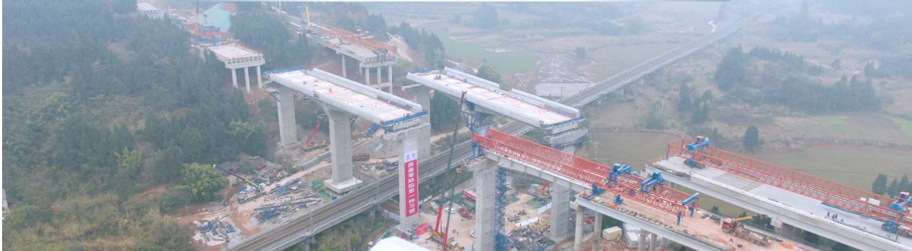
成南高速扩容项目上跨兰渝铁路大桥成功转体。蜀道集团供图
