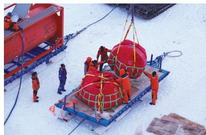
北京时间12月3日凌晨,工作人员在“雪龙2”号船侧冰面开展油囊装车作业。
