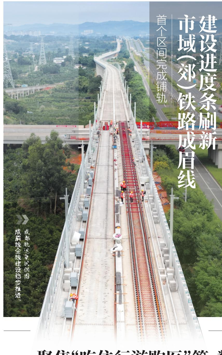
华西都市报讯(记者 杨芮雯)12月10日,记者从成都轨道集团获悉,9日下午,市域(郊)铁路成眉线秦皇寺站至官塘站区间完成铺轨。这是成眉线首个完成铺轨的区间,标志着线路建设已逐渐转入轨道铺设与机电安装的新阶段,为后续供电、通信信号接入等工序的推进奠定了基础。
