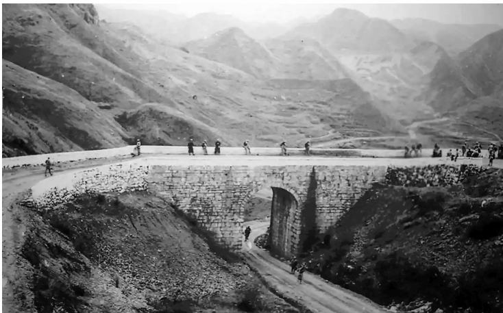
师生们组建的“湘黔滇旅行团”正徒步经过贵州镇远鹅翅膀桥。
